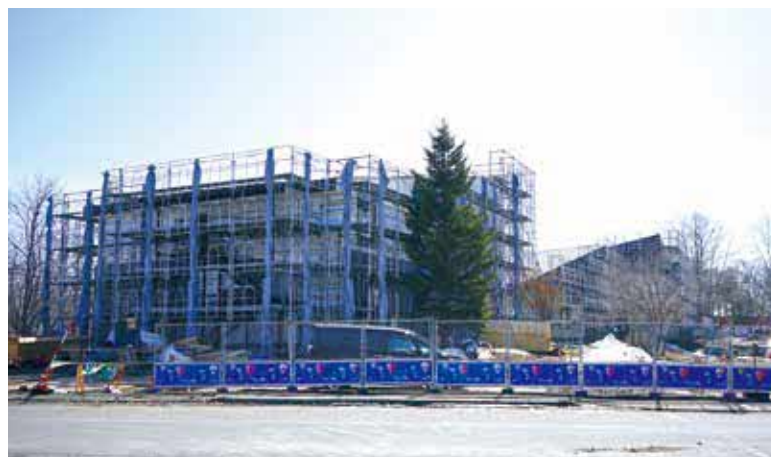
建設中の憩の家かや沼
